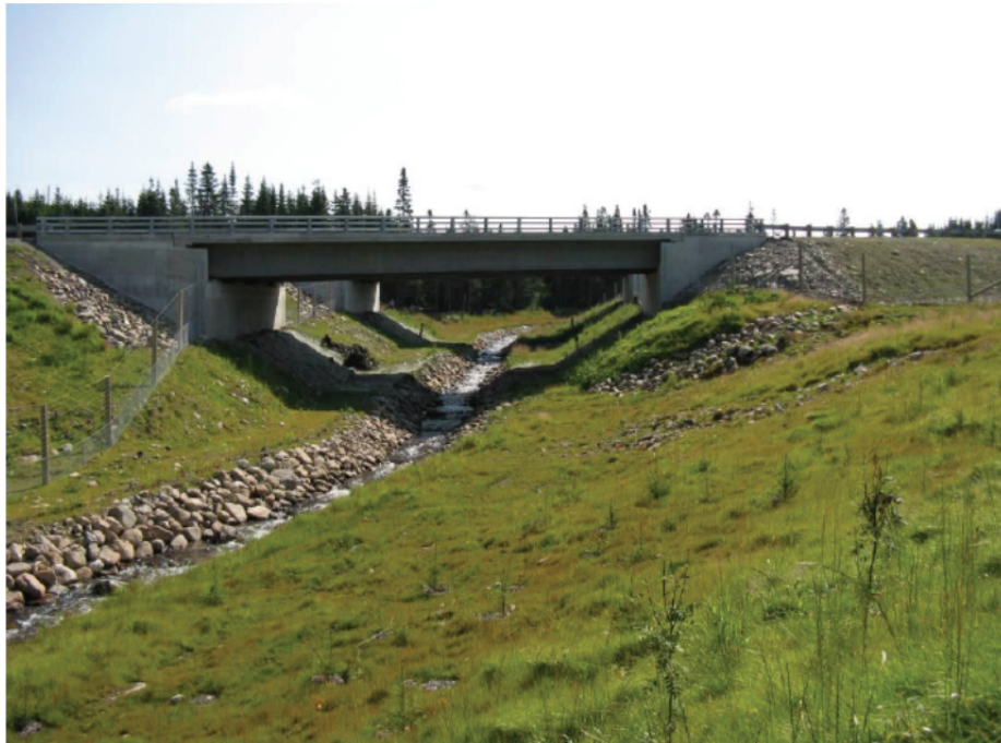
Photographie #3 Aménagement du lit majeur du cours d'eau - Route 175 (Photo Maryse Boucher)
