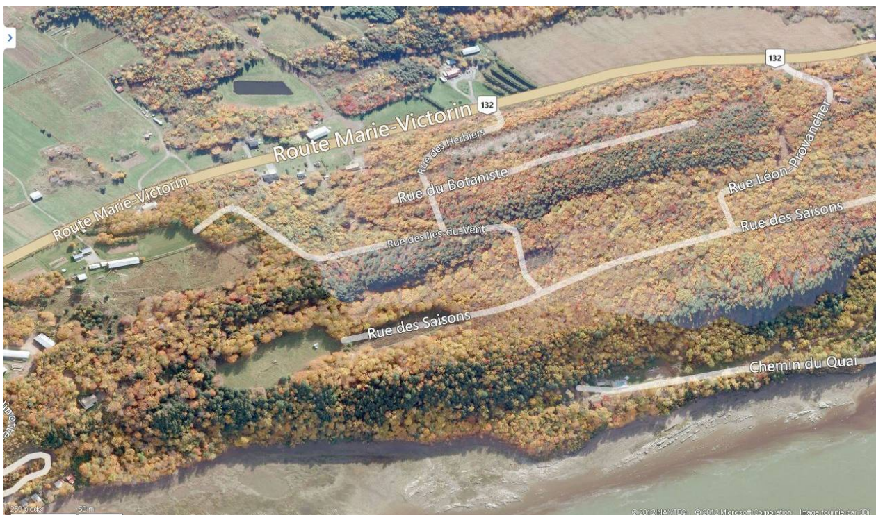
Le site de Bois Saint-Laurent, avant les travaux
