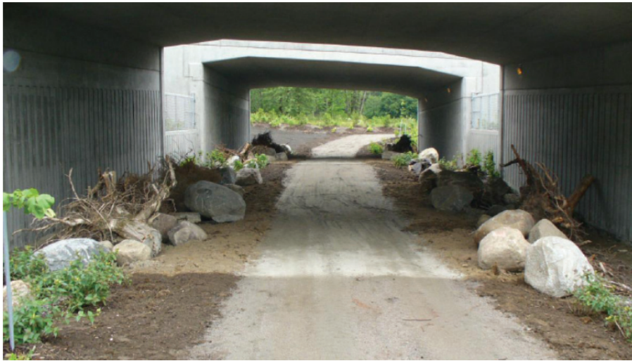
Photographie #5 Tunnel mixte - boulevard Robert-Bourassa à Québec
